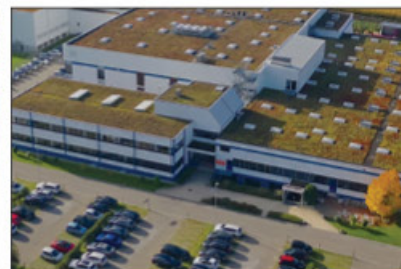
IQAir AG Technology Center Steinach, Ελβετία
